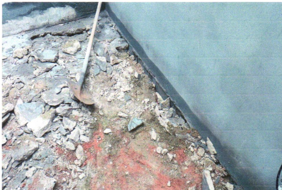
FOTO 02 – Demolição manual de piso cimentado sobre lastro de concreto - Rev 01
