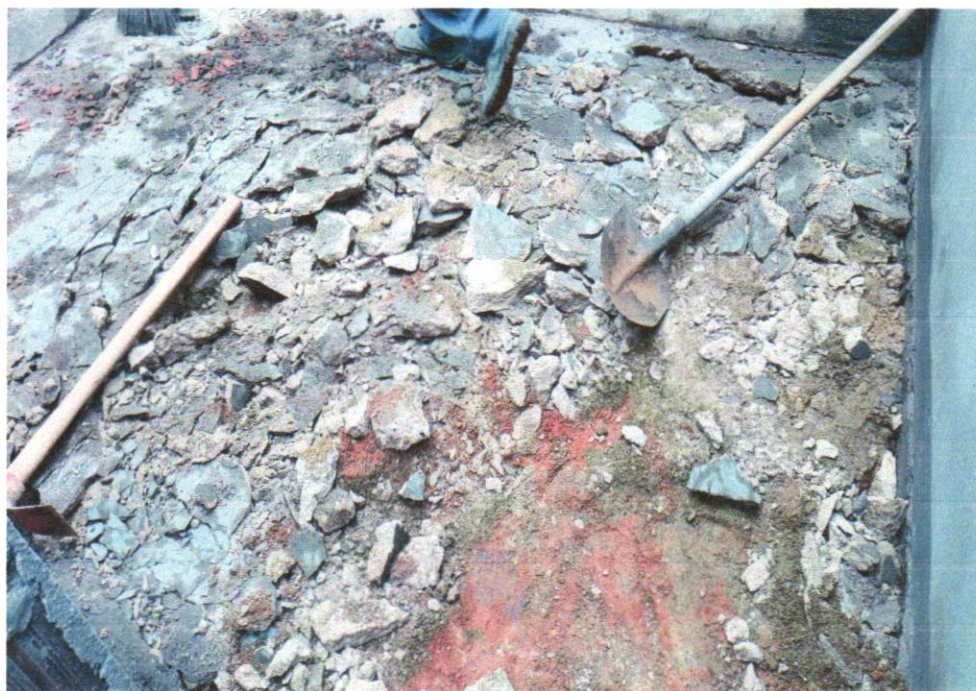
FOTO 01 - Demolição manual de piso cimentado sobre lastro de concreto - Rev 01
