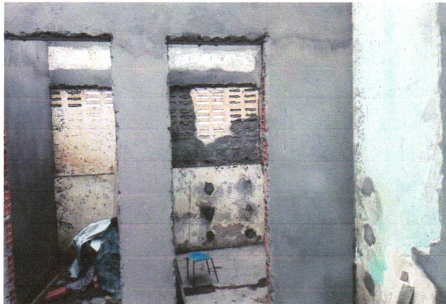
FOTO 10 – MASSA ÚNICA, PARA RECEBIMENTO DE PINTURA OU CERÂMICA, ARGAMASSA INDUSTRIALIZADA, PREPARO MECÂNICO, APLICADO COM EQUIPAMENTO DE MISTURA E PROJEÇÃO DE 1,5 M 3 /H EM FACES INTERNAS DE PAREDES, ESPESSURA DE 5MM, SEM EXECUÇÃO DE TALISCAS. AF_06/2014
