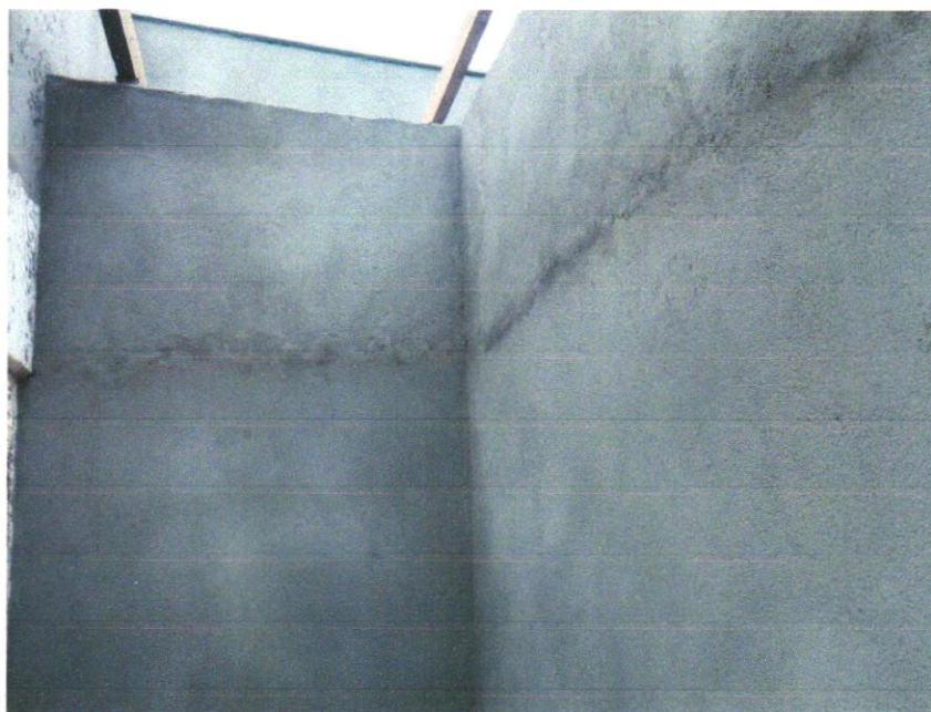
FOTO 11 – MASSA ÚNICA, PARA RECEBIMENTO DE PINTURA OU CERÂMICA, ARGAMASSA INDUSTRIALIZADA, PREPARO MECÂNICO, APLICADO COM EQUIPAMENTO DE MISTURA E PROJEÇÃO DE 1,5 M 3 /H EM FACES INTERNAS DE PAREDES, ESPESSURA DE 5MM, SEM EXECUÇÃO DE TALISCAS. AF_06/2014
