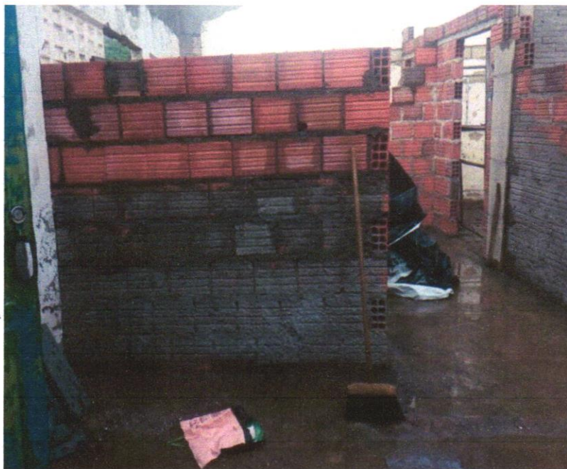
FOTO 08 – CHAPISCO APLICADO EM ALVENARIA (COM PRESENÇA DE VÃOS) E ESTRUTURAS DE CONCRETO DE FACHADA, COM EQUIPAMENTO DE PROJEÇÃO. ARGAMASSA TRAÇO 1:3 COM PREPARO EM BETONEIRA 400
