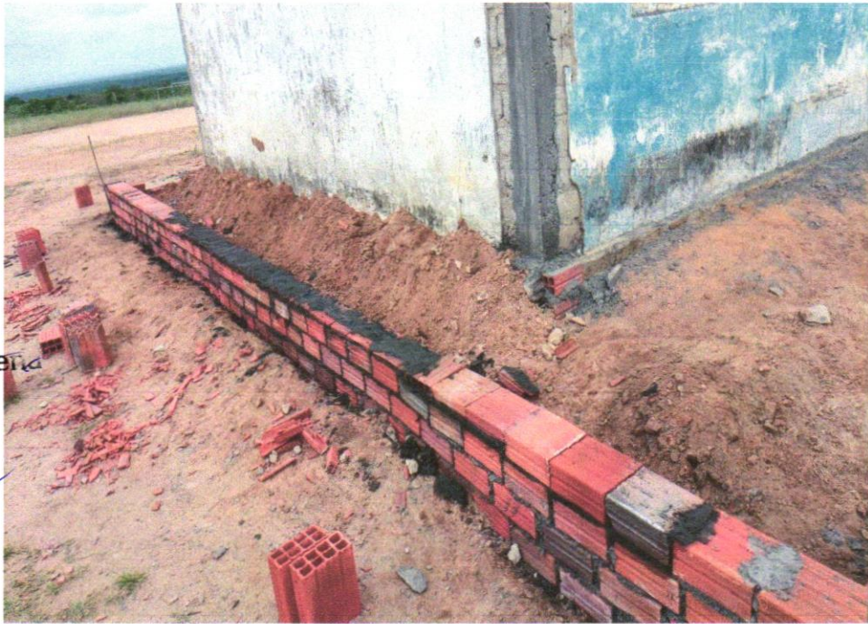
FOTO 06 – ALVENARIA DE VEDAÇÃO DE BLOCOS CERÂMICOS FURADOS NA HORIZONTAL DE 9X19X29 CM (ESPESSURA 9 CM) E ARGAMASSA DE ASSENTAMENTO COM PREPARO EM BETONEIRA. AF_12/2021
