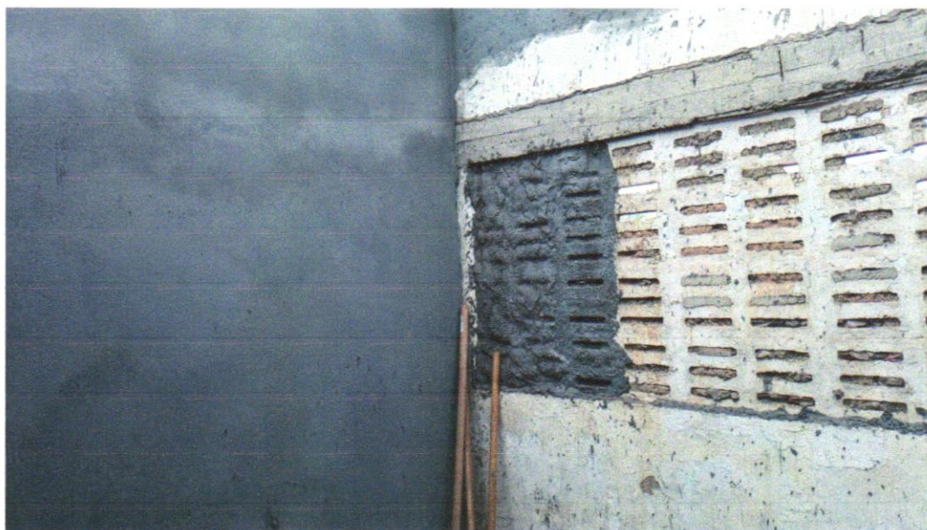
Foto 11 - MASSA ÚNICA, PARA RECEBIMENTO DE PINTURA OU CERÂMICA, ARGAMASSA INDUSTRIALIZADA, PREPARO MECÂNICO, APLICADO COM EQUIPAMENTO DE MISTURA E PROJEÇÃO DE 1,5 M3/H EM FACES INTERNAS DE PAREDES, ESPESSURA DE 5MM, SEM EXECUÇÃO DE TALISCAS. AF_06/2014
